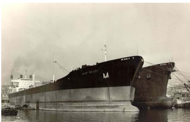
In allestimento ai cantieri a fianco dell'Agip Roma
