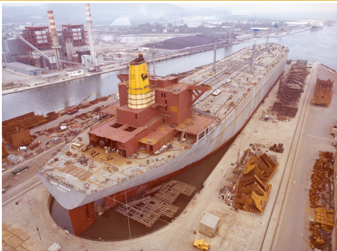
La nave in avanzata fase di costruzione
