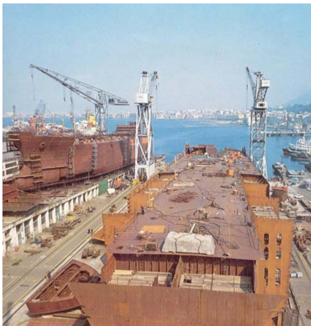
L'Agip Ravenna durante i lavori di costruzione. A sinistra in fase avanzata di costruzione è l'Agip Gela
