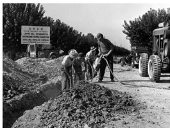
Posa del metanodotto Cortemaggiore - Cremona - Casalbuttano - Soresina - Ripalta - Caviaga.
