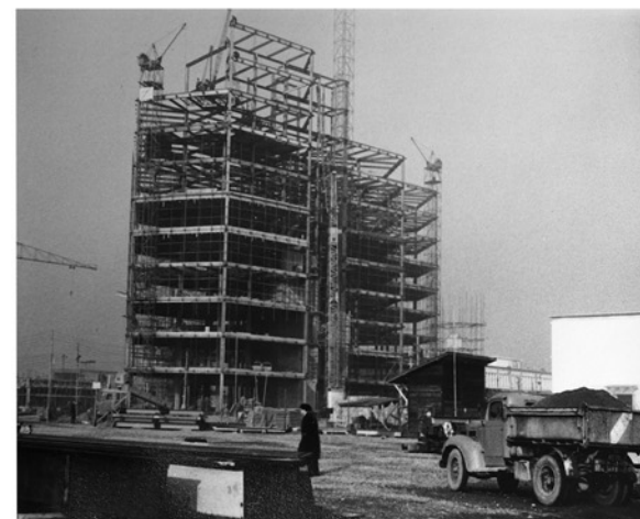
San Donato Milanese - 8 dicembre 1956: Il primo palazzo uffici (Snam) in costruzione.
