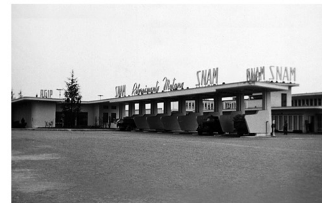
San Donato Milanese - 12 aprile 1956: la vecchia stazione di rifornimento metano SNAM.
