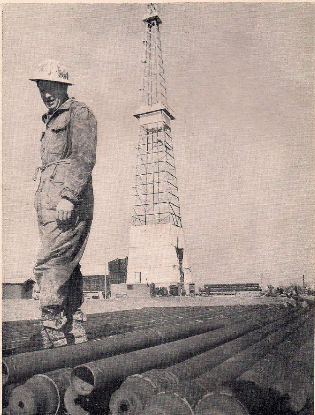
*Un aspetto del cantiere di Cortemaggiore, dell'AGIP. Si vede nel fondo la grande sonda rotary IDECO, che può perforare fino a 5.000 metri di profondità. La torre di questa poderosa sonda è alta 63 metri e i suoi motori possono sviluppare una potenza fino a 2.000 cavalli.*
