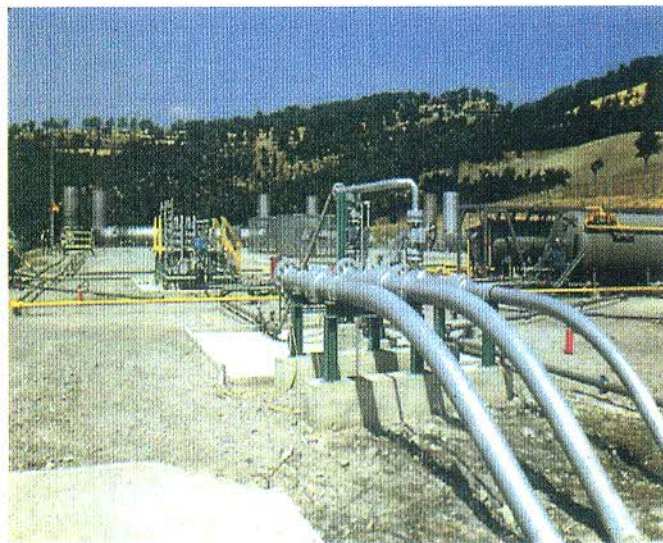
Area pozzi Monte Alpi 1 e 2
