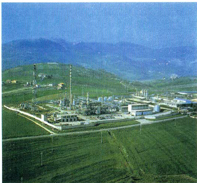
Impianto di desolforazione di Cupello
