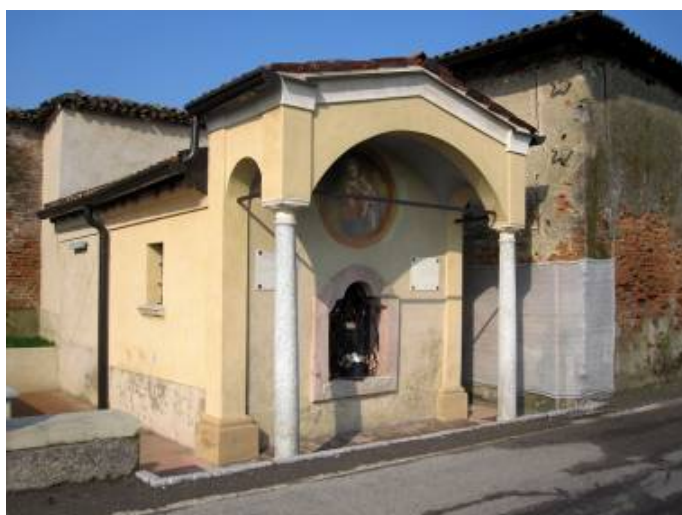
22 - Cappella – ossario di Mezzano
