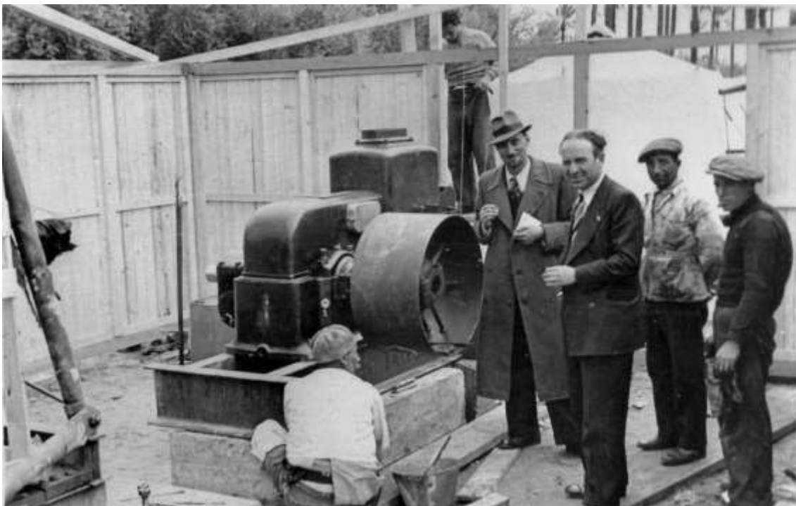
Figura 3 - 7 aprile 1938 Pozzo Giamaa el Turk, Carlo Sarti (con il cappotto) ispeziona la sistemazione e fissaggio del motore dell'impianto di perforazione
