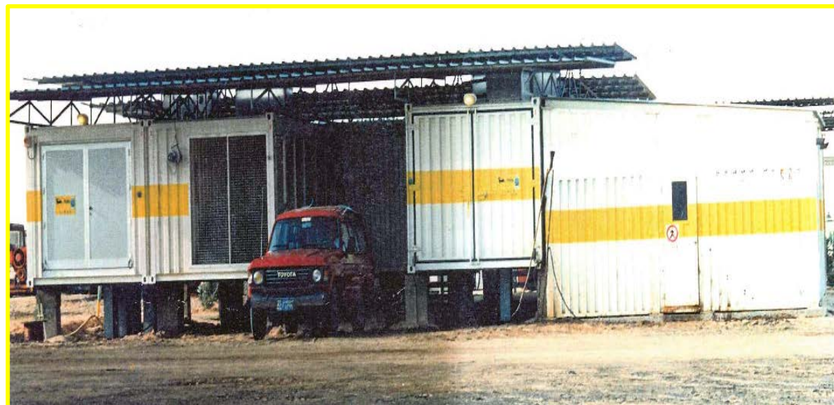
Moduli pre-assemblati per i quadri di potenza e controllo
