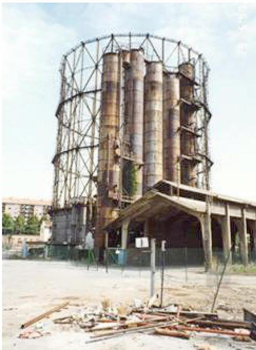
Il gasometro, struttura ibrida fra l'edificio e la macchina, è l'elemento più originale dei luoghi della produzione del gas. Oltre a testimoniare una precisa fase storica nel progresso produttivo dell'energia, esso rappresenta un simbolo dello sviluppo dell'ingegneria civile ed in particolare della carpenteria metallica reticolare.
