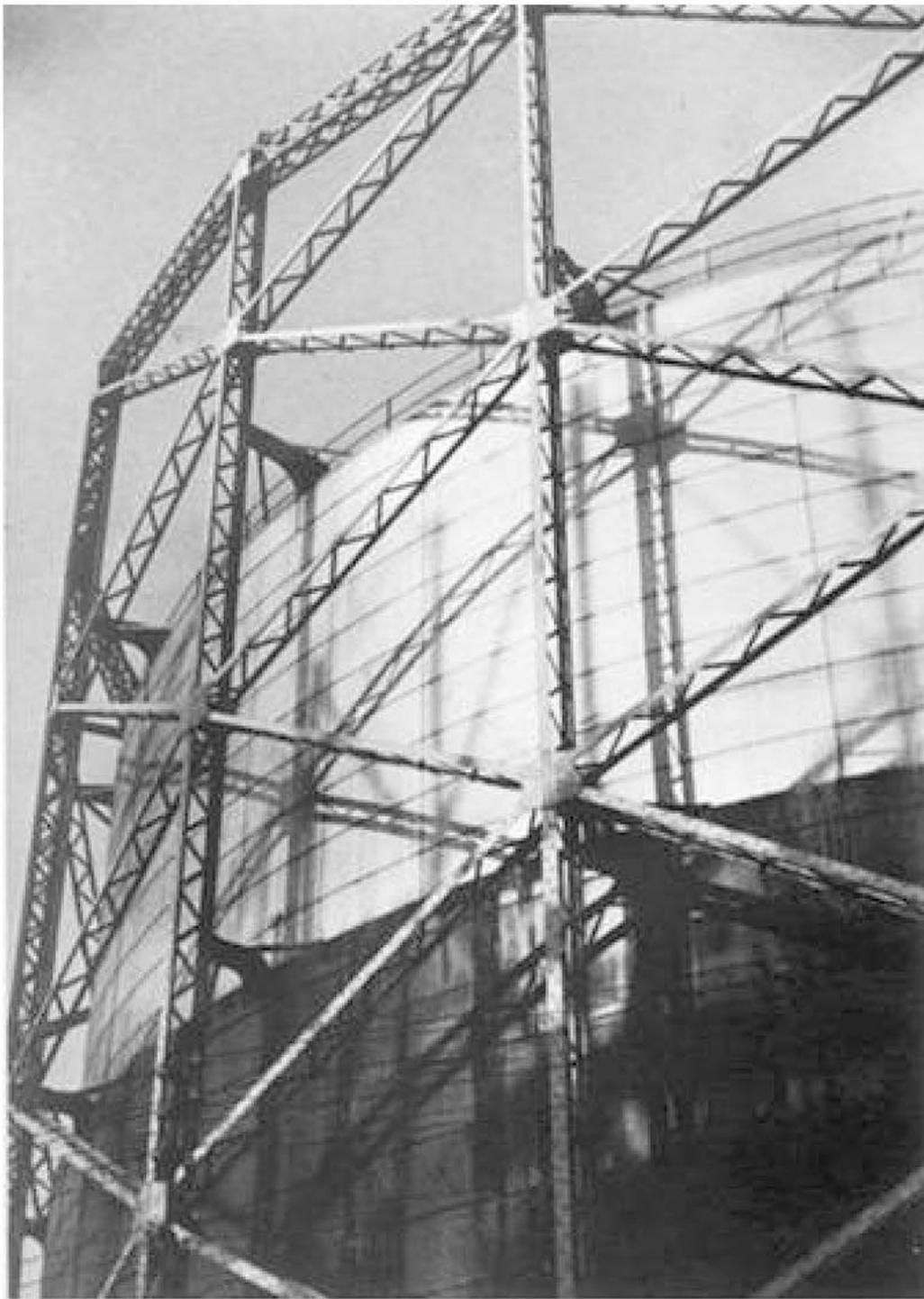
La trasparente struttura reticolare esterna, in acciaio, la sola visibile oggi che i gasometri sono in disuso, ha dunque il solo scopo di far scorrere e guidare le carrucole. La maglia reticolare si sviluppa su più livelli, tanti quanti sono le corone mobili, concepiti ognuno come enormi travi reticolari anulari.
