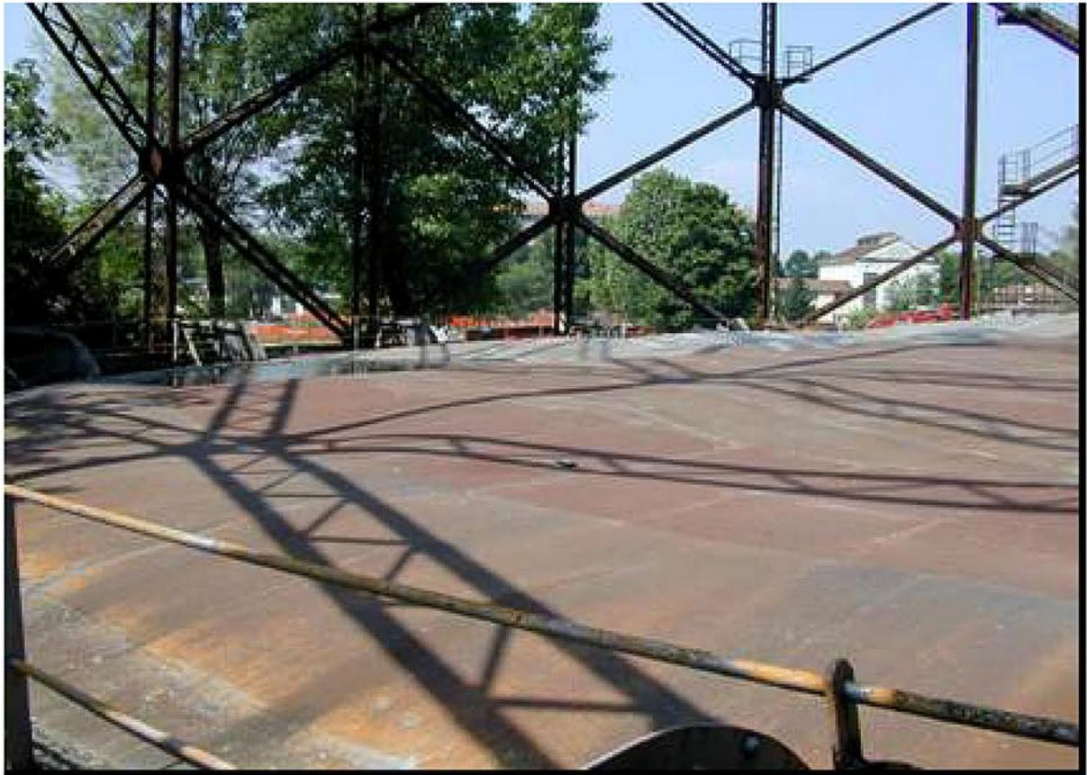
La calotta di copertura, di grande luce e priva di irrigidimenti atti a garantirle una autoportanza stabile, funziona come una tensostruttura: prima la pressione dell'acqua, poi quella del gas sostengono la membrana mantenendola in trazione. E' sempre la spinta del gas a sollevare la campana, che ha una configurazione a telescopio: raggiunta la massima altezza, prima di uscire dalla vasca, s'innesta automaticamente per mezzo di giunti anulari idraulici ad una corona anulare.
