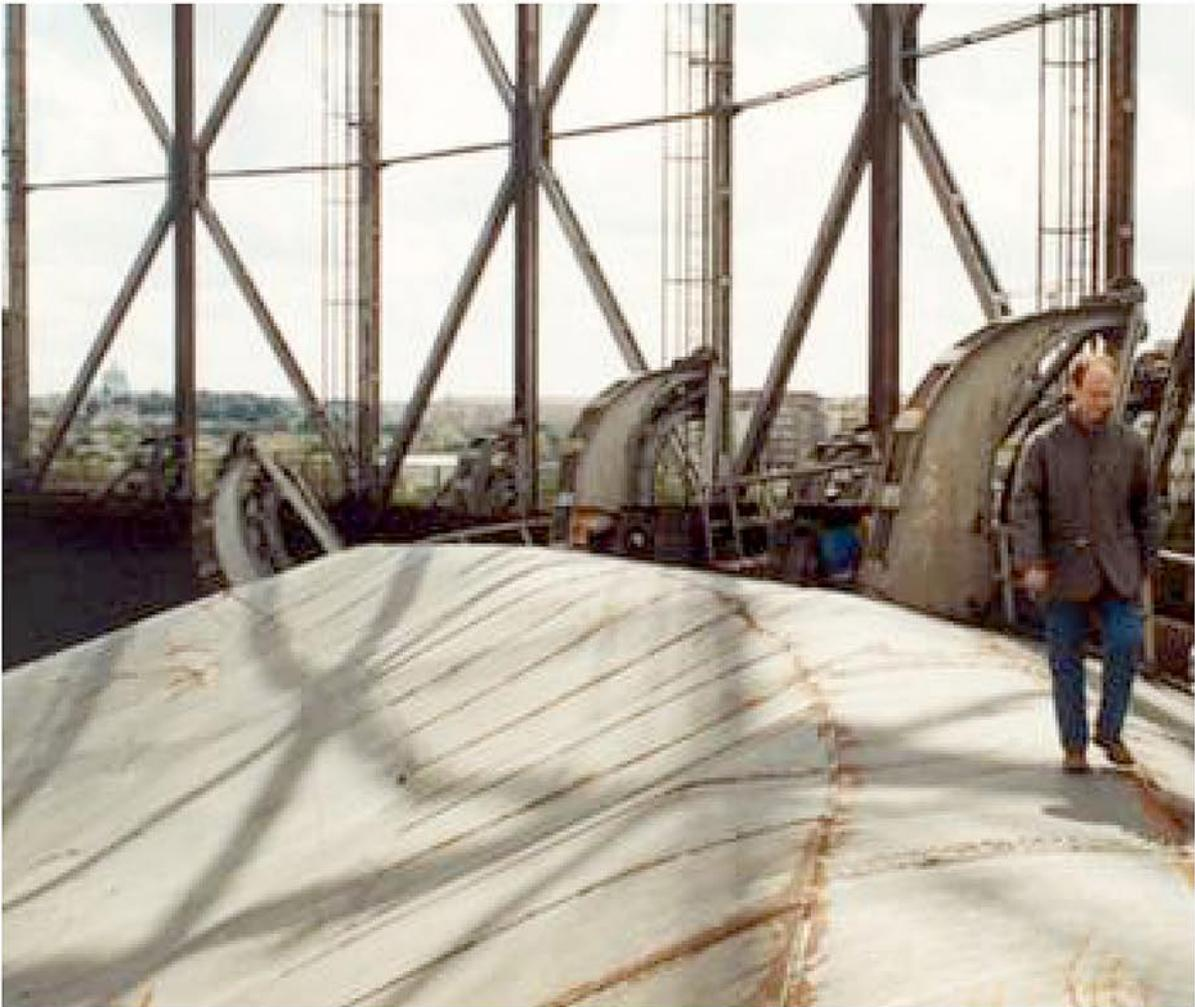
La campana è guidata, nei suoi movimenti di ascesa e discesa, da carrucole fissate sull'orlo superiore e che scorrono lungo montanti esterni verticali collegati tra loro in modo rigido e disposti secondo i vertici di un poligono regolare, nel quale è inscritto il diametro massimo della campana gasometrica.
