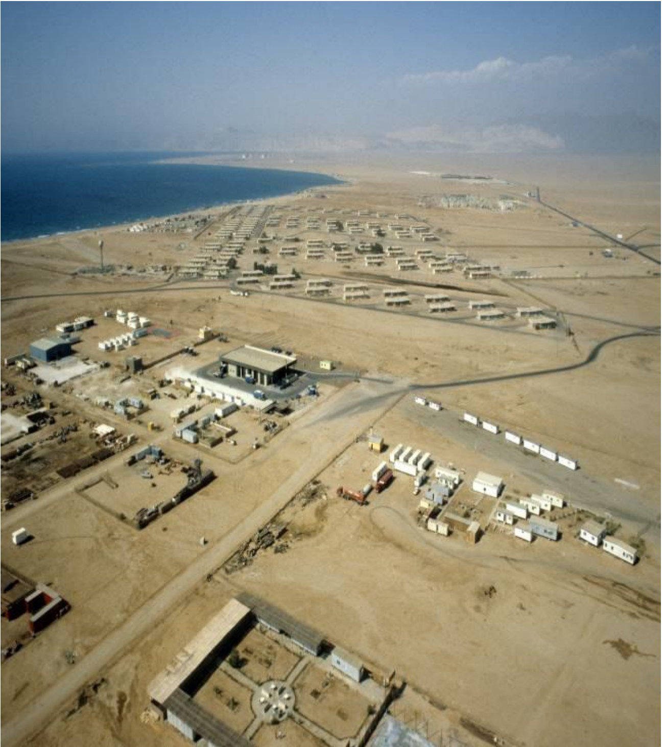
Foto aerea dell'area del centro olio di Belayim
