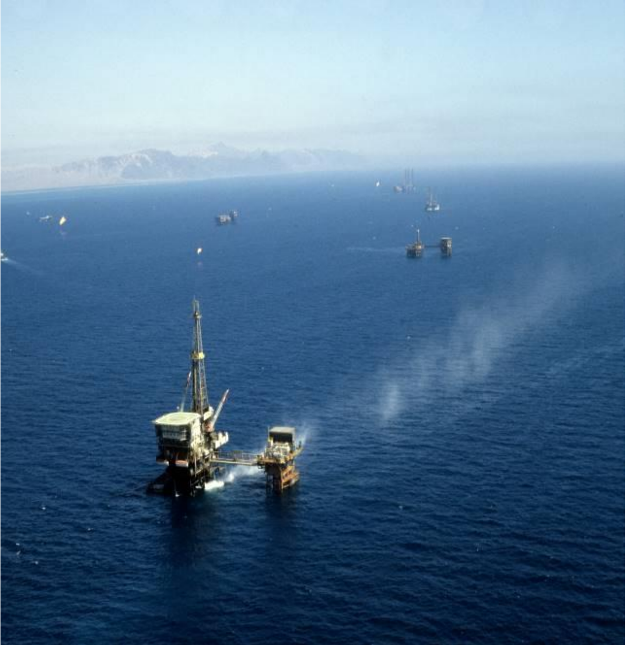
Piattaforme di Belaym Marine
