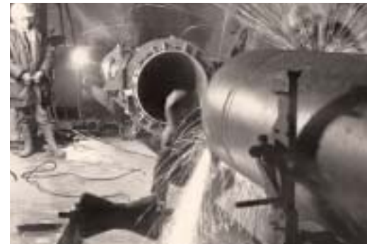
Posa del gasdotto da 36" Olanda-Italia, Svizzera, 1973
