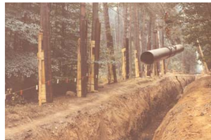
Sfilamento con teleferica gasdotto da 36" Olanda-Italia, Svizzera, 1973
