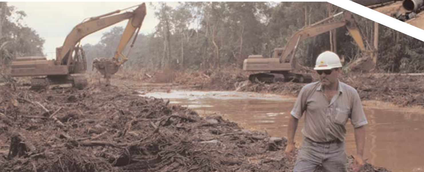
Preparazione scavo, gasdotto da 36" PGU III, Malesia, 1996
