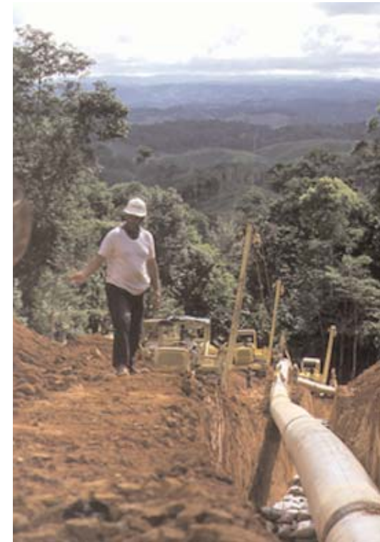
Posa oleodotto da 30" Vasconia-Covenas, Colombia, 1995
