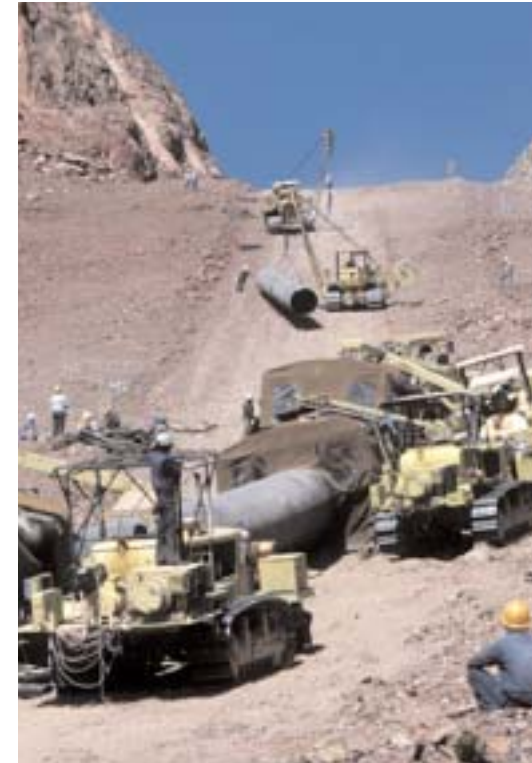
Accoppiamento e saldatura dell'oleodotto da 56" Khurais-Yanbu, Arabia Saudita, 1987
