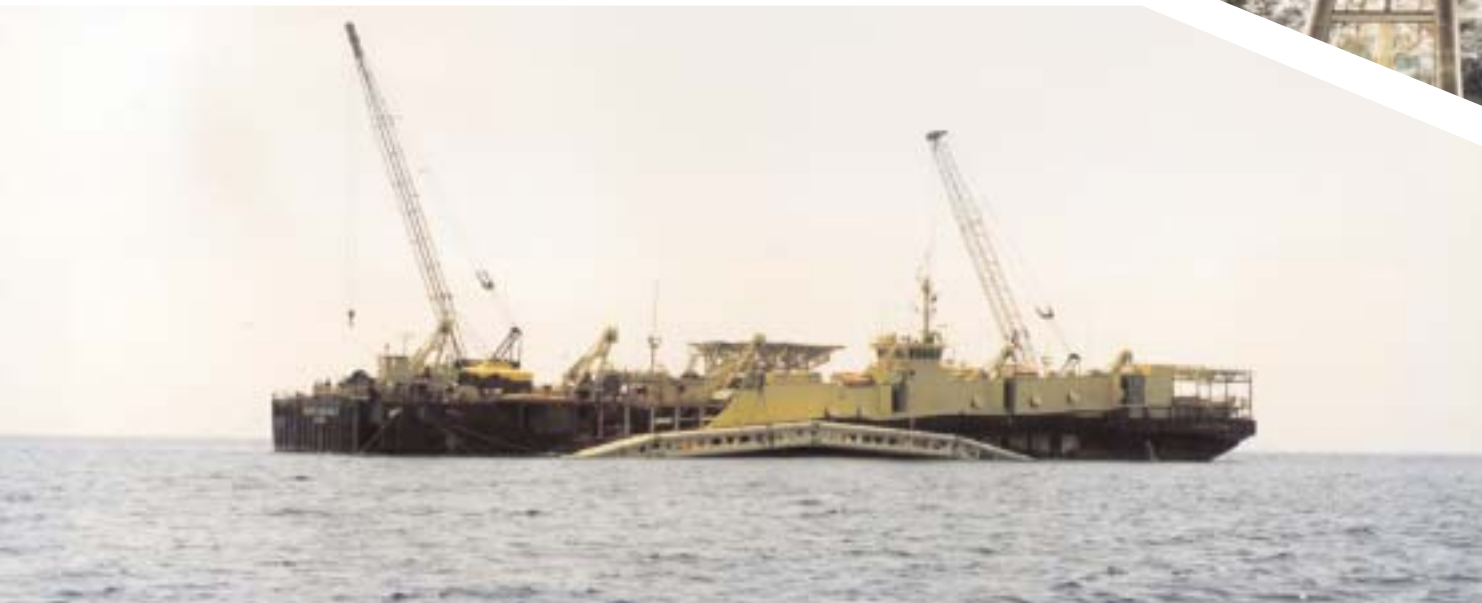
Castoro 5, prove di posa in acque profonde, linea da 16" Line, Canale di Sicilia, 1976
