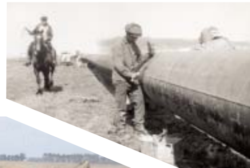
Pulizia della saldatura, gasdotto da 30" Santa Cruz - Buenos Aires, Argentina, 1962
