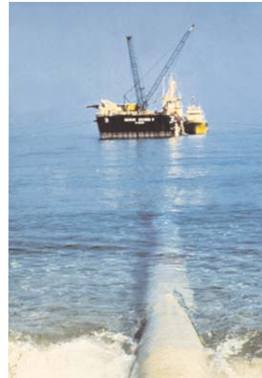
Castoro 5, approdo del gasdotto da 10", Stretto di Messina, Italia, 1974
