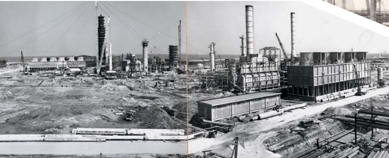
Panoramica durante il montaggio della raffineria di Ferrara, Italia, 1962
