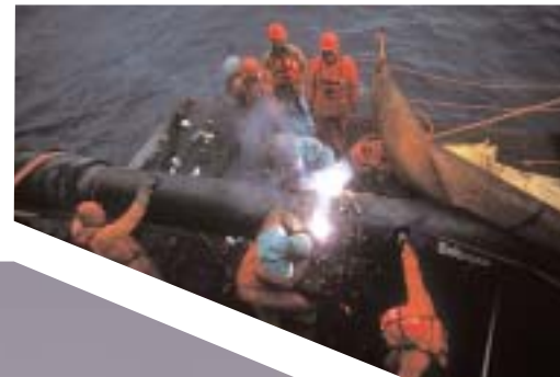
Castoro II, tie-in, gasdotto da 22" attraverso lo Stretto di Gibilterra, Spagna, 1995
