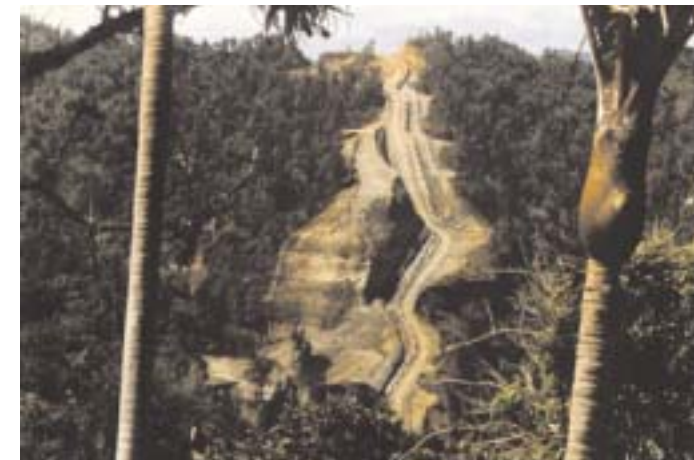
Sfilamento del gasdotto da 34" Oanui-Huntly, Nuova Zelanda, 1975
