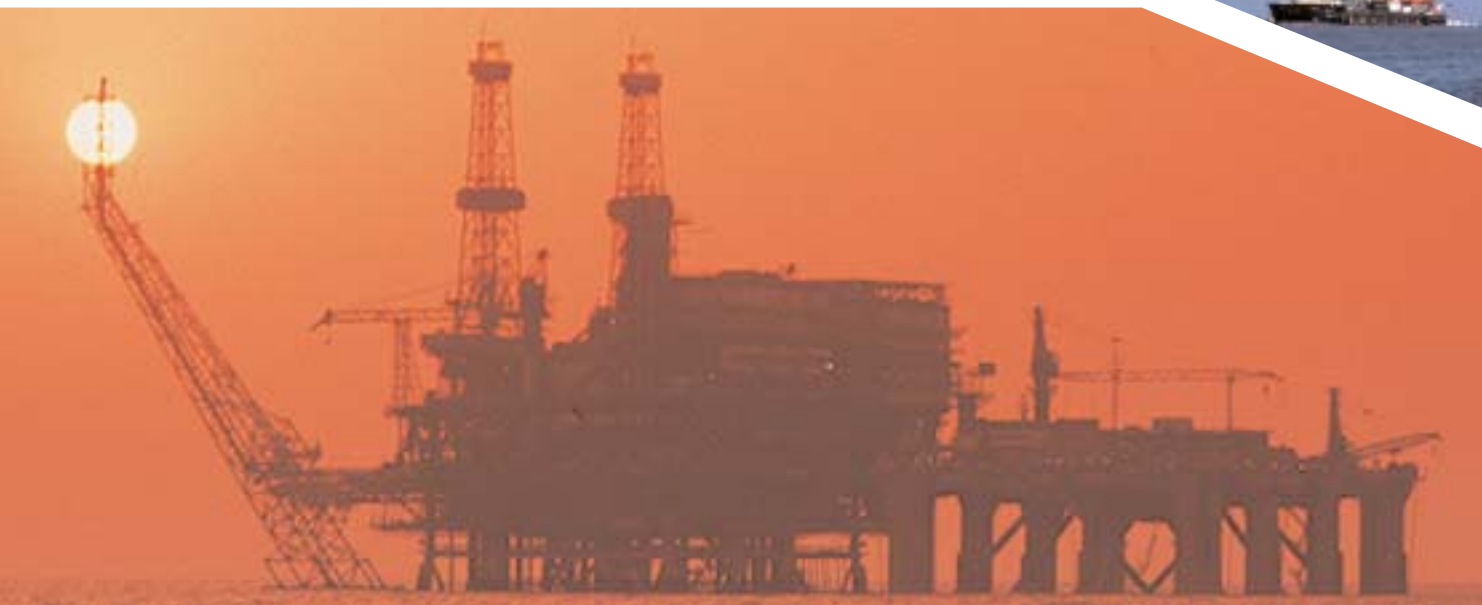
Piattaforma di produzione in fase di completamento, campo Bouri, Mar Mediterraneo, Libia, 1988
