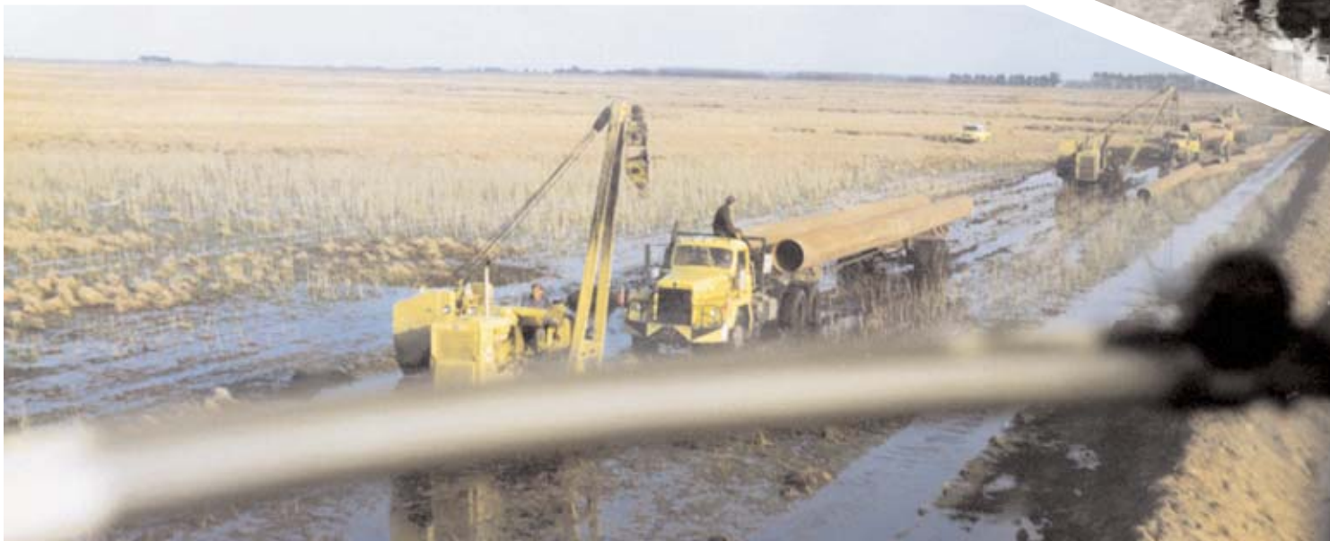
Sfilamento nella pampa allagata, gasdotto da 30" Santa Cruz - Buenos Aires, Argentina, 1962
