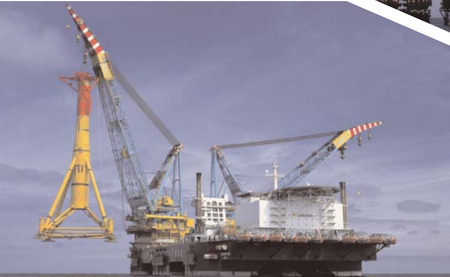
Saipem 7000, installazione jacket, campo Varg, Mare del Nord, Norvegia, 1997
