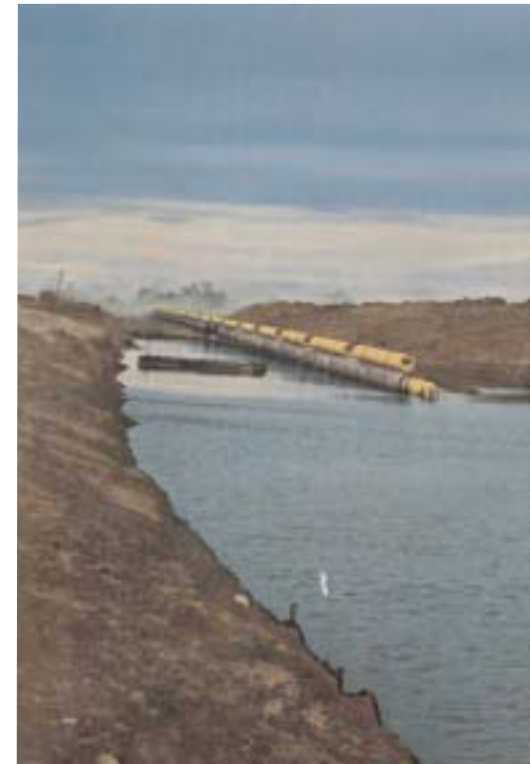
Attraversamento del Rio Negro, gasdotto da 30" Santa Cruz - Buenos Aires, Argentina, 1962
