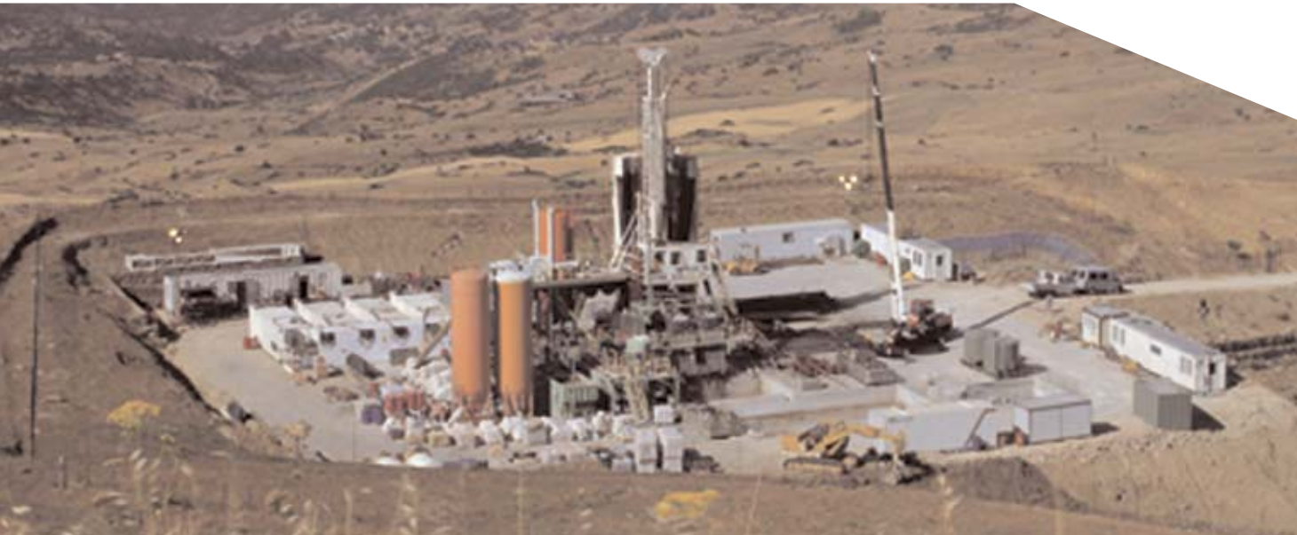
G125, perforazione pozzo Monte Ferrante 1, Enna, Italia, 1997
