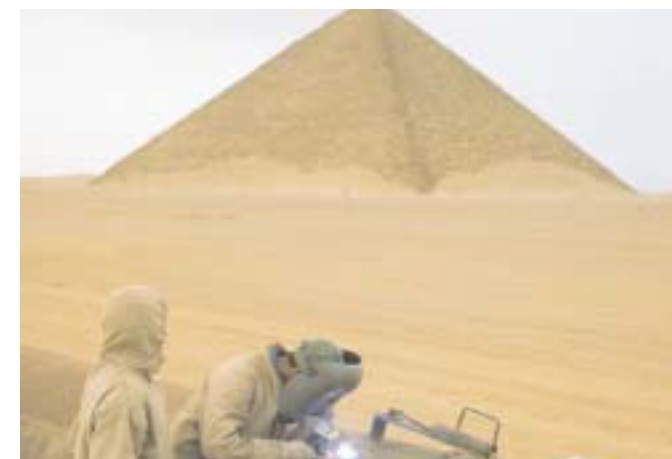
Saldatura del doppio oleodotto da 42" Suez - Alessandria, Egitto, 1974
