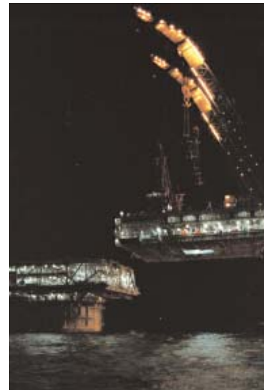
Saipem 7000, installazione modulo superiore in posizionamento dinamico, Progetto Hoover-Diana, Golfo del Messico, USA, 1999
