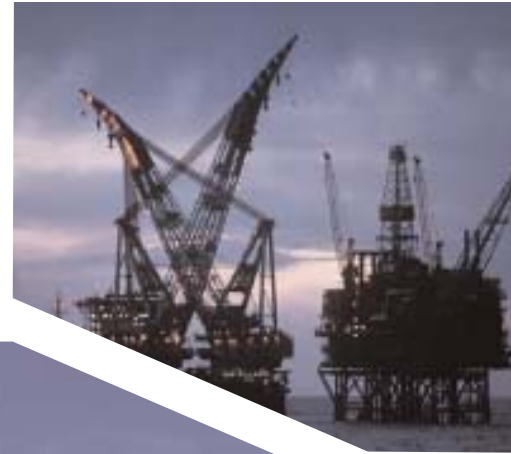
Installazione del modulo alloggi, piattaforma Tiffany, Mare del Nord, Gran Bretagna, 1992
