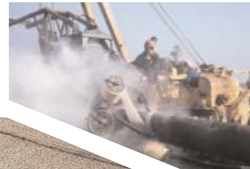
Fasciatura e posa, oleodotto da 16" Gahuati - Siliguri, India, 1960
