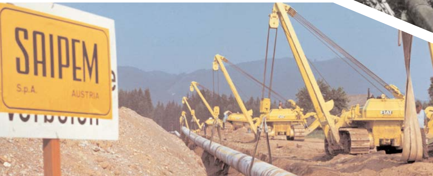
Posa del gasdotto da 36" dal confine ceco all'Italia, Austria, 1972
