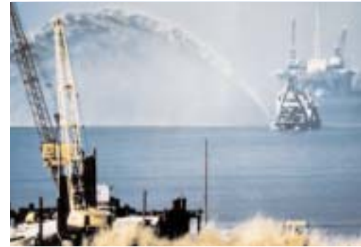
Castoro 10 e Castoro Sei, Scavo e posa, linee da 20" e 30", Progetto Dong, Mare del Nord, Danimarca, 1983
