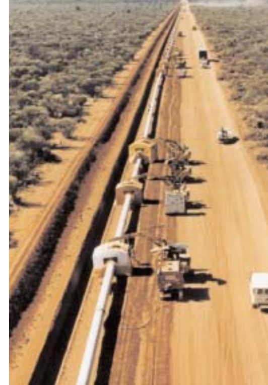
Saldatura del gasdotto da 26" Dampier- Perth, Western Australia, 1983
