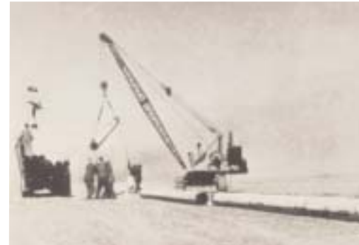
Sfilamento tubi, oleodotto da 12" Line Suez- Cairo, Egitto, 1954
