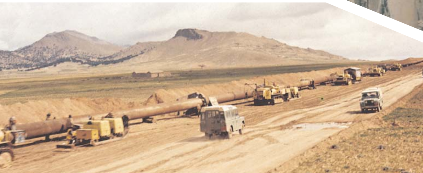
Saldatura del gasdotto da 48" Transmed, Tunisia, 1979
