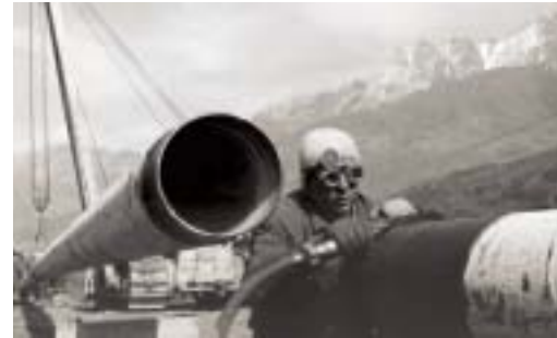
Prima della posa nello scavo, oleodotto da 26" Genoa - Ingolstadt, bosco di Memmingen, Germania, 1963
