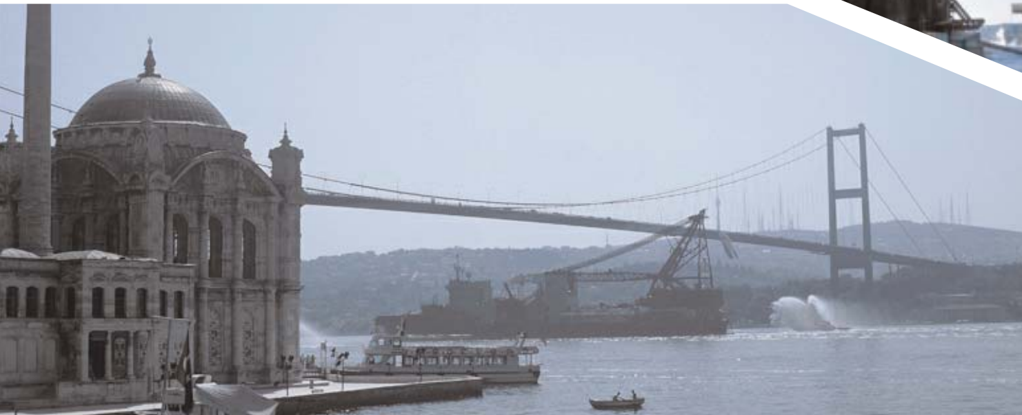
Castoro Otto, attraversamento del Bosforo, gasdotto da 24" Blue Stream, Turchia, 2001
