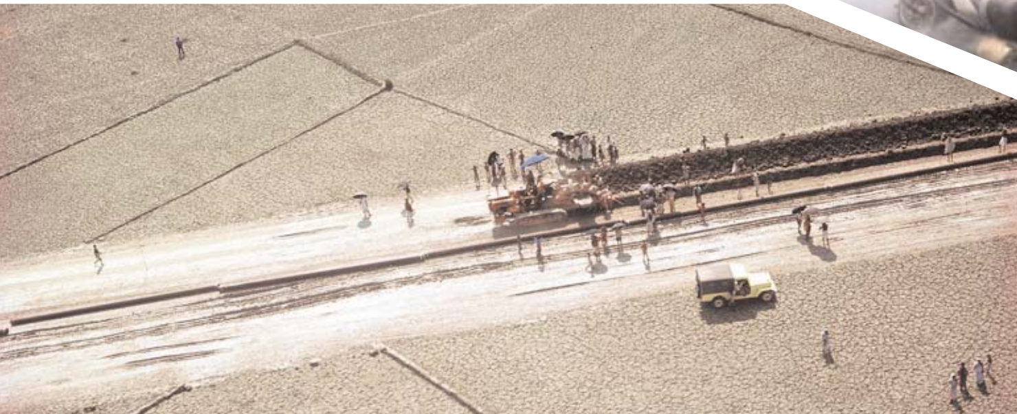
Saldatura in risaia, oleodotto da 16" Gahuati - Siliguri, India, 1960
