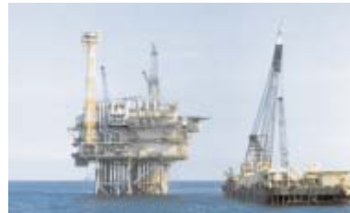
In avvicinamento alla piattaforma Forties, oleodotto da 32", Mare del Nord, Scozia, 1975
