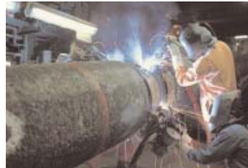
Castoro II, tie-in, gasdotto da 22" attraverso lo Stretto di Gibilterra, Spagna, 1995
