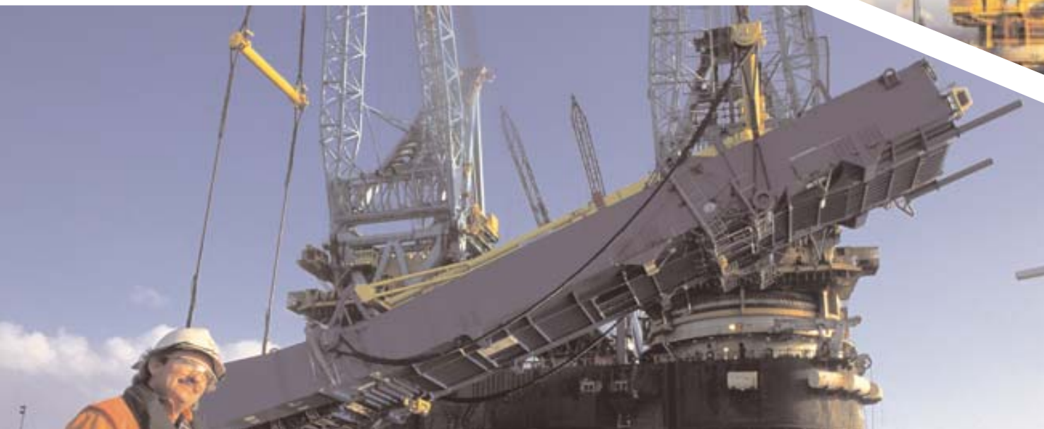
Saipem 7000, installazione della parte inferiore della torre per la posa in J, Rotterdam, Olanda, 1999
