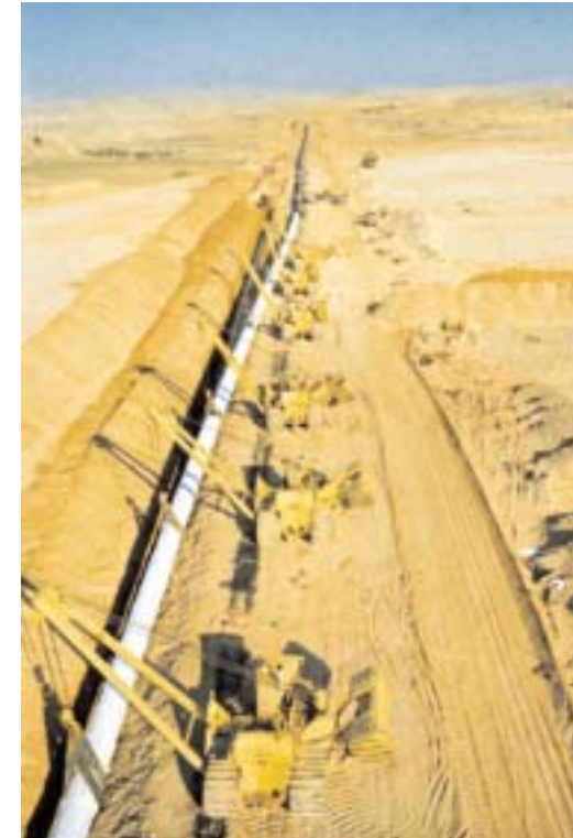
Posa del gasdotto da 48" Transmed, Algeria, 1979
