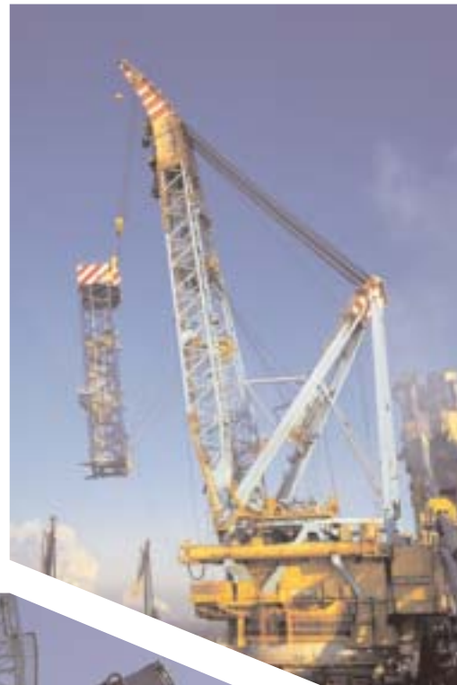
Saipem 7000, installazione della parte superiore della torre per la posa in J, Rotterdam, Olanda, 1999
