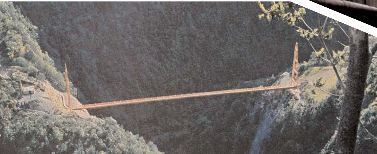
Attraversamento del torrente Varrone, oleodotto da 26" Genoa - Ingolstadt, Italia, 1961
