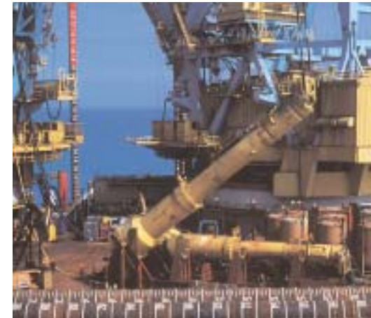
Micoperi 7000, inizio della battitura pali, piattaforma Tiffany, Mare del Nord, Gran Bretagna, 1992
