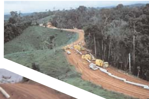
Saldatura oleodotto da 30" Vasconia-Covenas, Colombia, 1995
