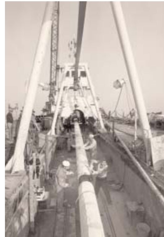
Castoro, linea di saldatura, oledotto da 30", Huelva, Spagna, 1966
