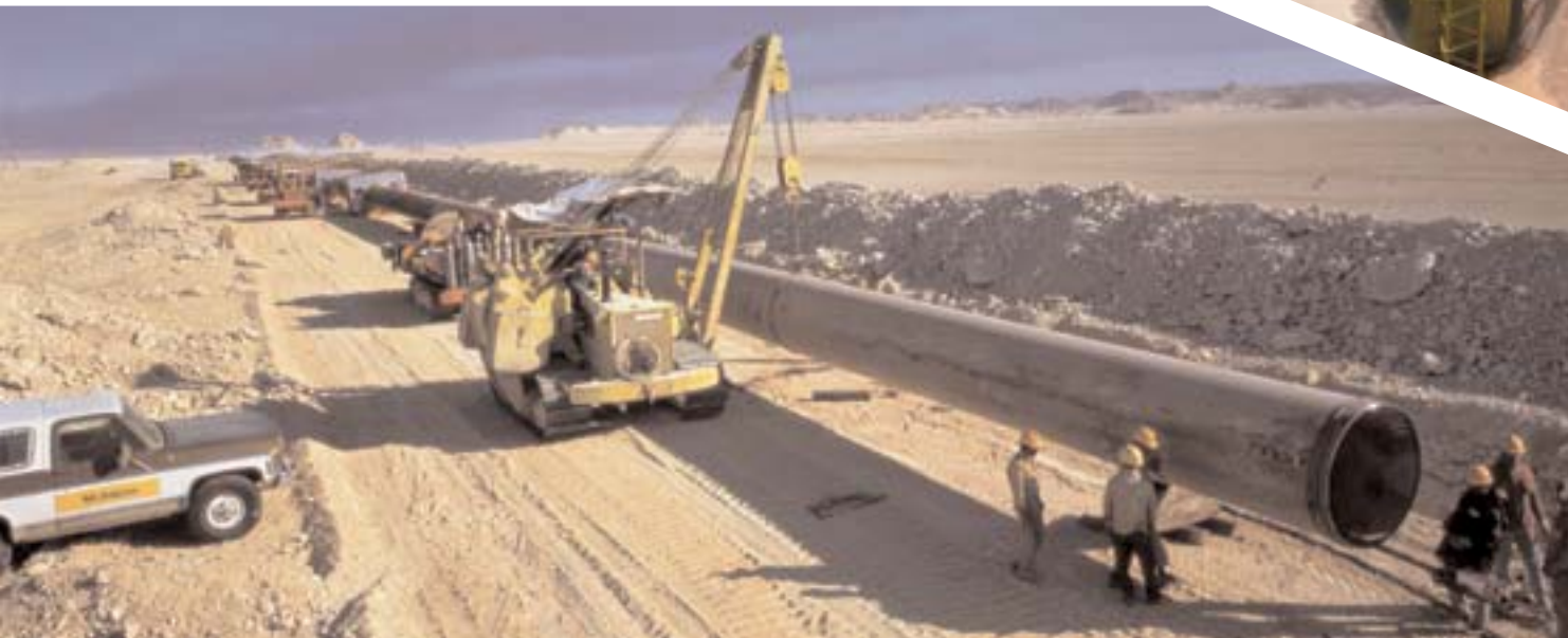
Accoppiamento e saldatura dell'oleodotto da 56" Khurais-Yanbu, Arabia Saudita, 1987
