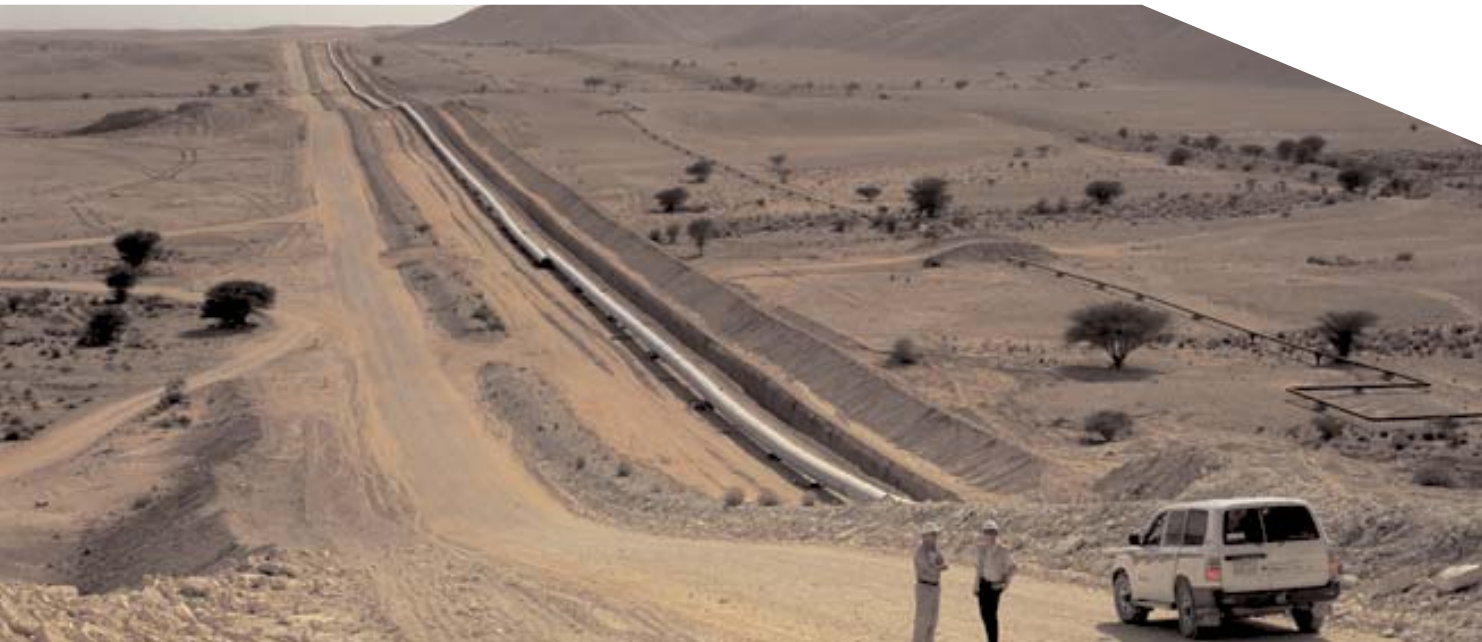
Condotta prima della posa nell'oscavo, gasdotto da 56" Hawiyah, Arabia Saudita, 1999
