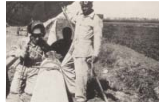
Saldatura, oleodotto da 12" Line Suez- Cairo, Egitto, 1955
