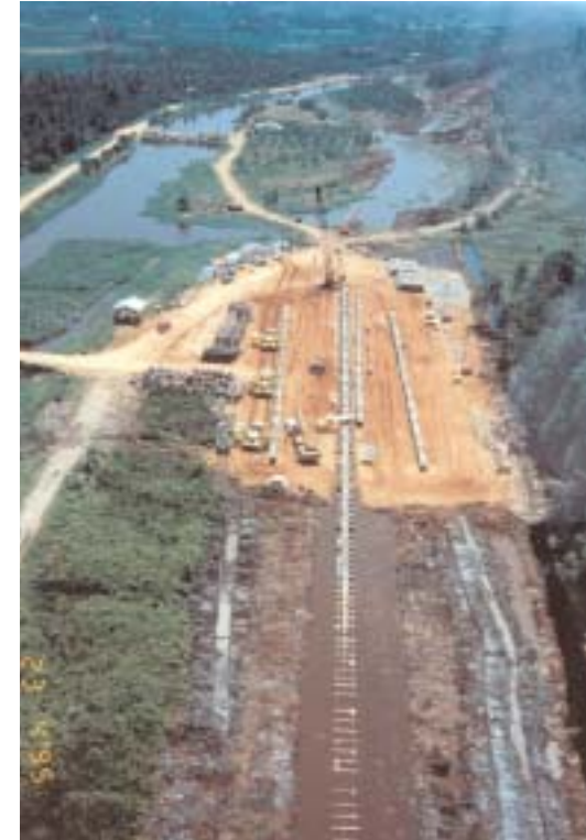
Cantiere di prefabbricazione e di varo, gasdotto da 36" PGU III, Malesia, 1996
