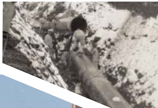
Accoppiamento con teleferica del gasdotto da 36" dal confine ceco all'Italia, Austria, 1972
