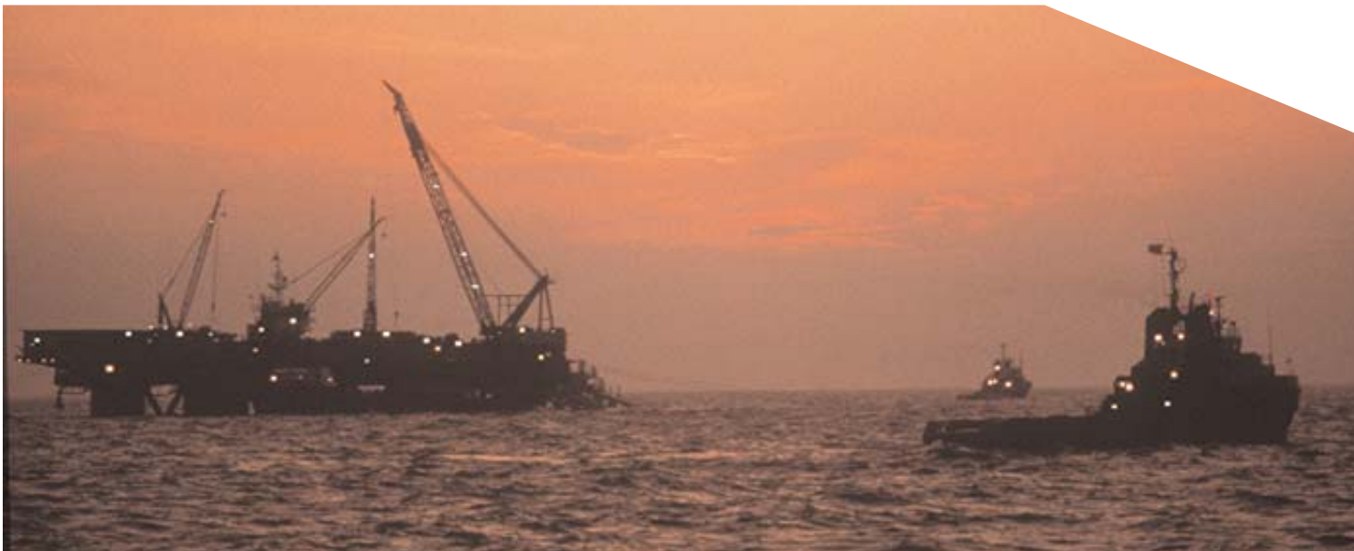
Semac 1, posa del gasdotto da 40" Zeepipe, Mare del Nord, 1991
