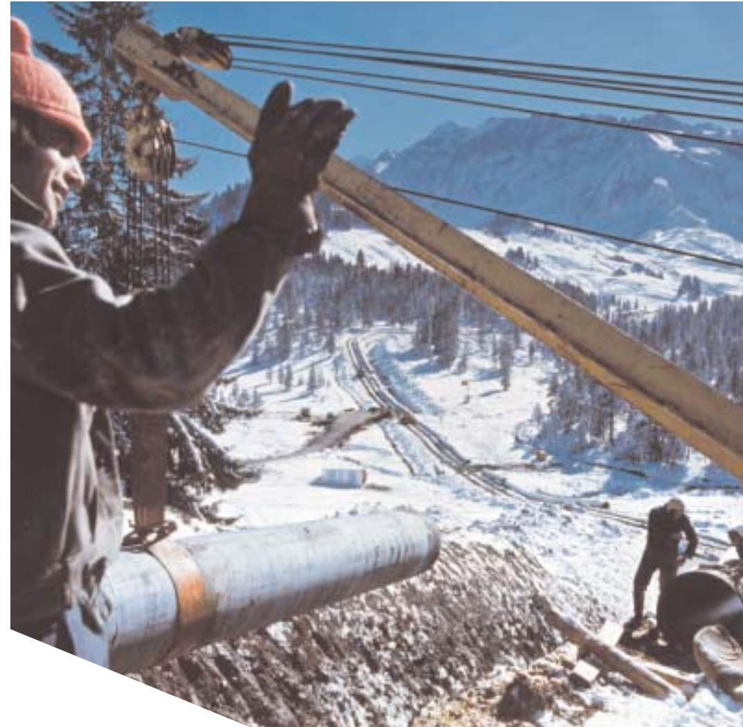
Fase di accoppiamento gasdotto da 36", Alpi della Carinzia, Austria, 1972
