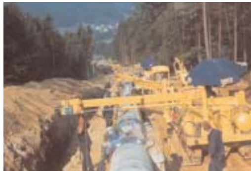
Accoppiamento con teleferica del gasdotto da 36" dal confine ceco all'Italia, Austria, 1972
