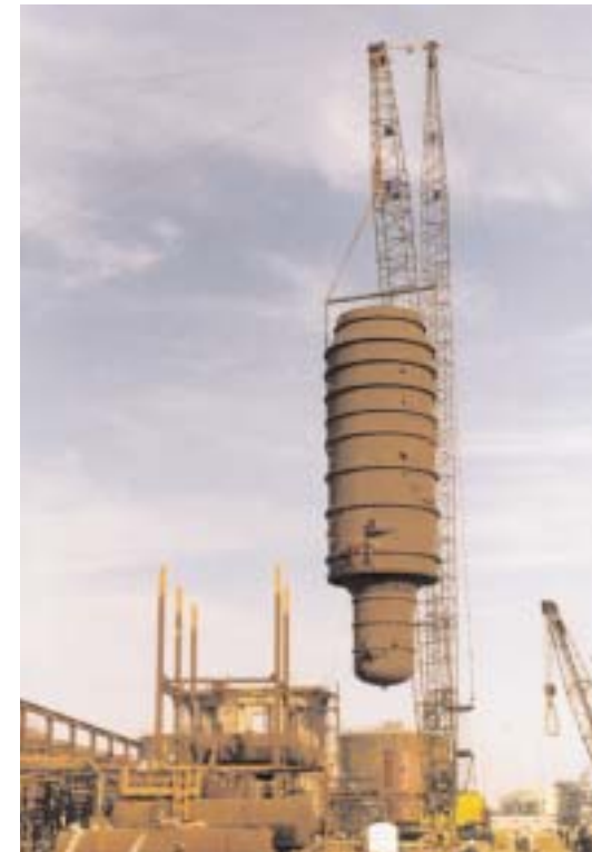
Montaggio dell'impianto per lubrificanti, Basrah, Iraq, 1979
