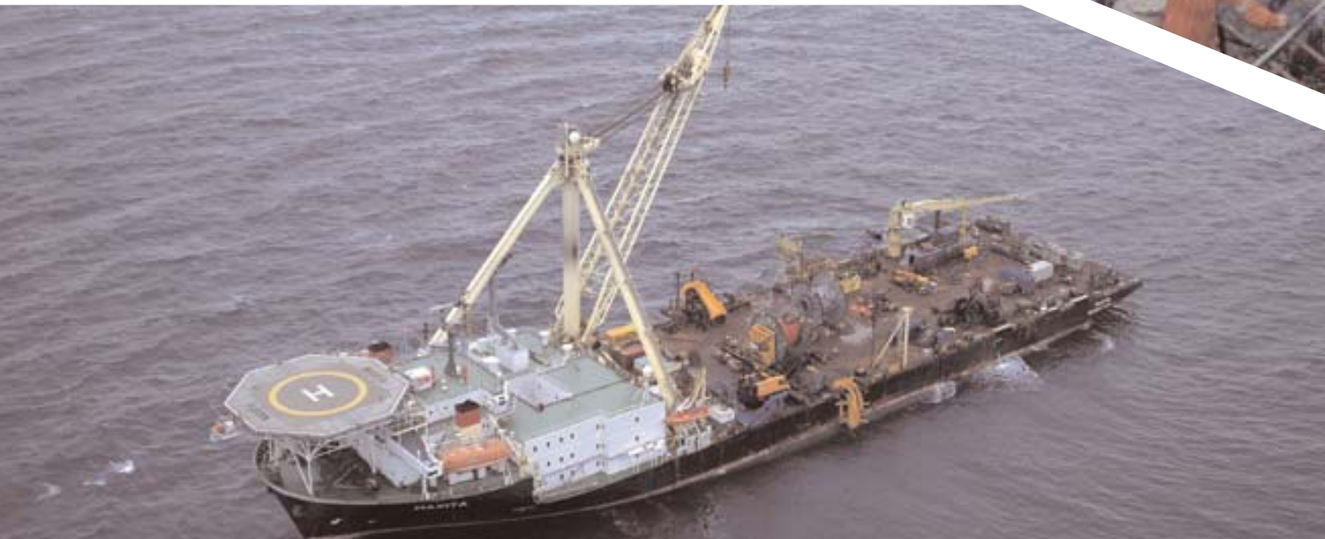
Maxita, installazione delle flowlines per FPSO Firenze, Campo Aquila, Mar Adriatico, Italia, 1997
