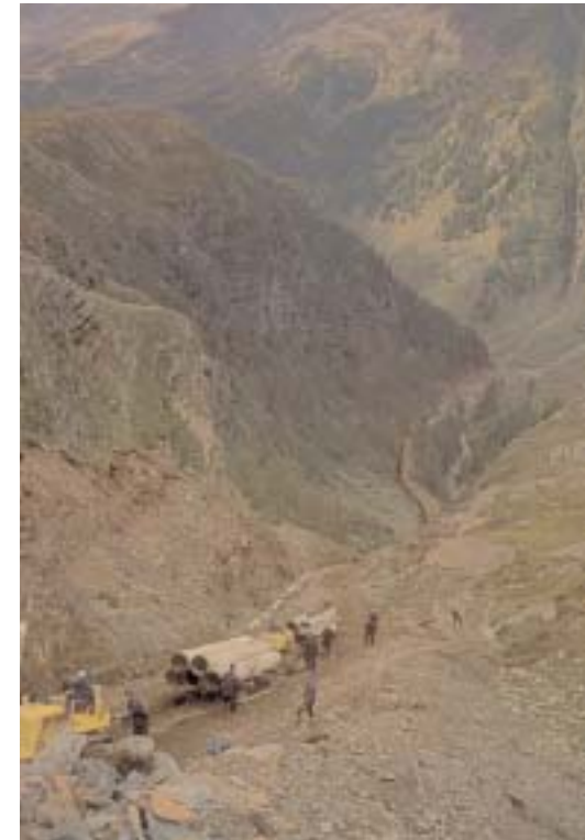
Sfilamento tubi, oleodotto da 26" Genoa - Ingolstadt, attraversamento delle Alpi, Italia, 1962
