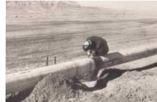
Saldatura, oleodotto da 12" Line Suez- Cairo, Egitto, 1955
