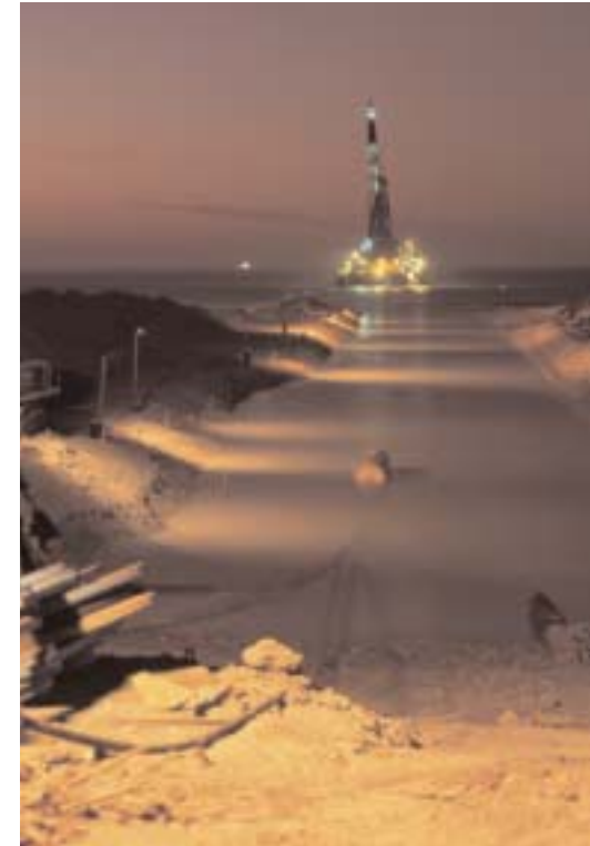
Castoro II, gasdotto da 22" attraverso lo Stretto di Gibilterra, approdo costa marocchina, 1995
