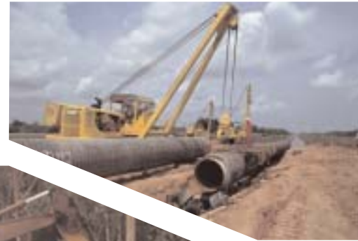
Preparazione per il varo, gasdotto da 36" PGU III, Malesia, 1996
