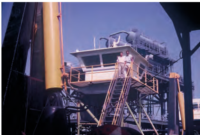
IMINOCO Rostam field: Lavori installazione piattaforma produzione e Living Quarters
