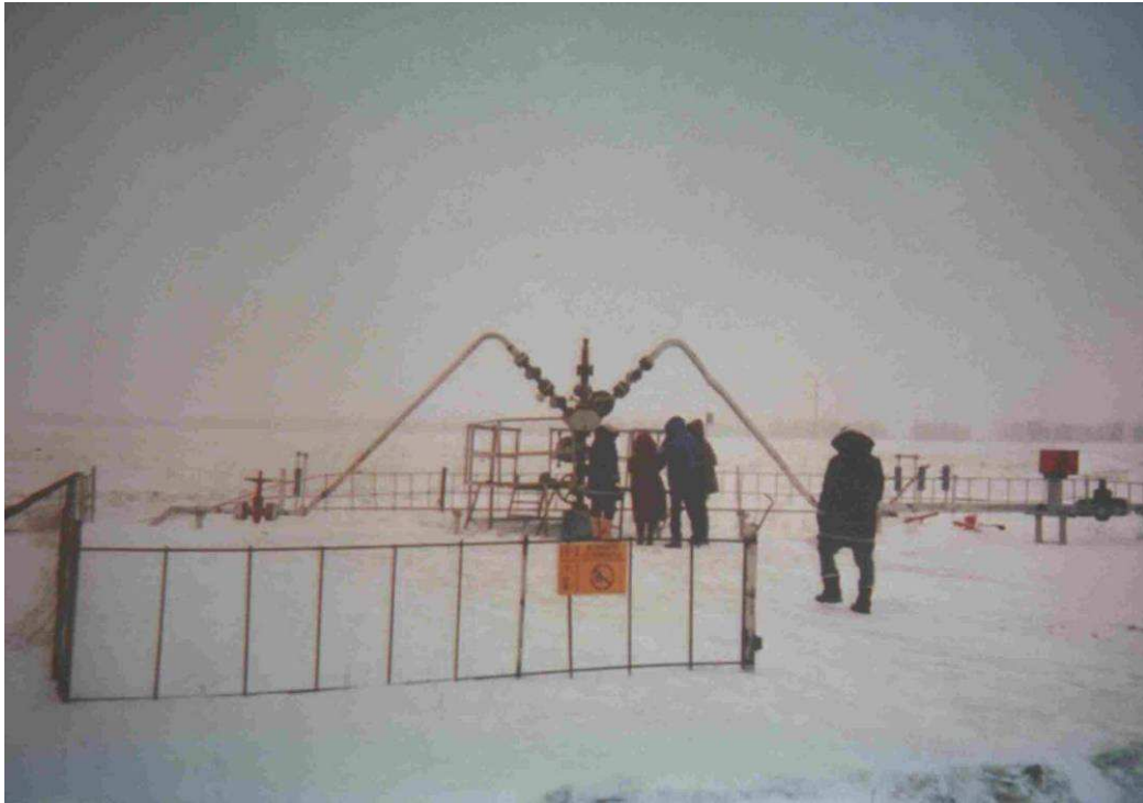
Visita ad un pozzo in produzione con testa pozzo completamente esterna
