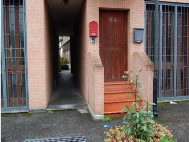
Dal parcheggio, corridoio di passaggio al cortile interno
