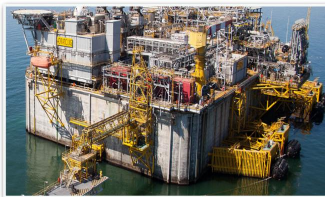
Il terminale Adriatic LNG è una struttura per la ricezione, lo stoccaggio e la rigassificazione del gas naturale liquefatto (GNL).
